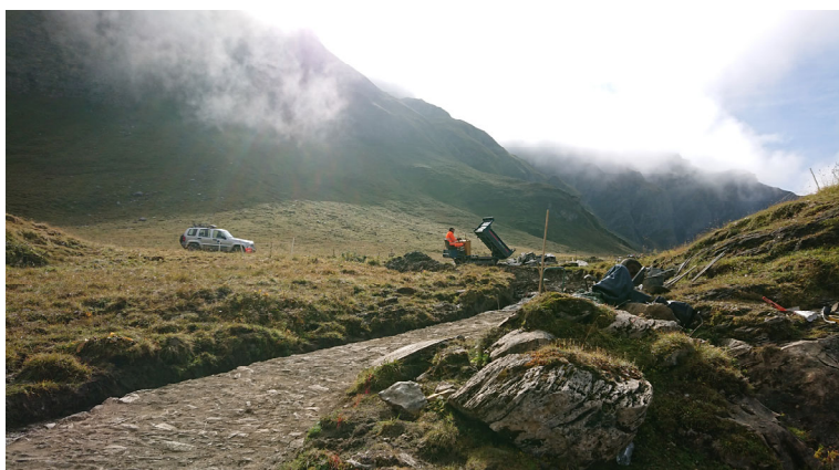
Abbildung 23: Sanierte Pflästerung oberhalb der Alp Tomül.
