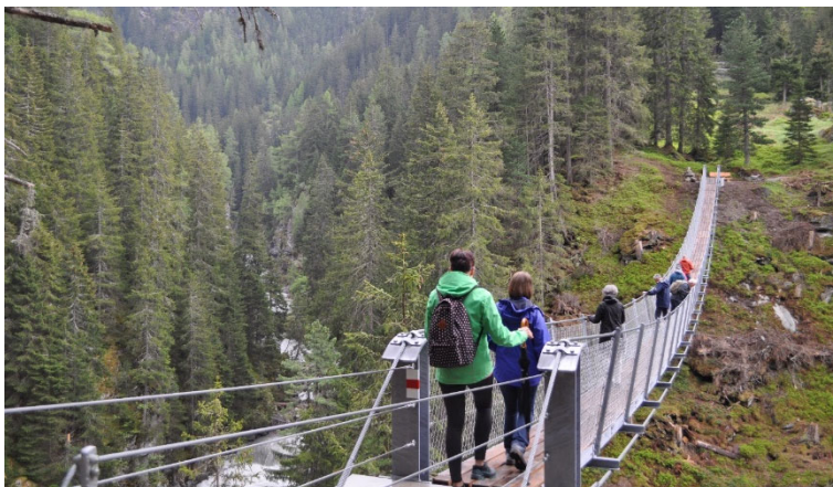
Abbildung 7: Gemeinsame Begehung des neuen Waldwegs Innerferrera mit der Hängebrücke beim Sommerauftakt Viamala.
