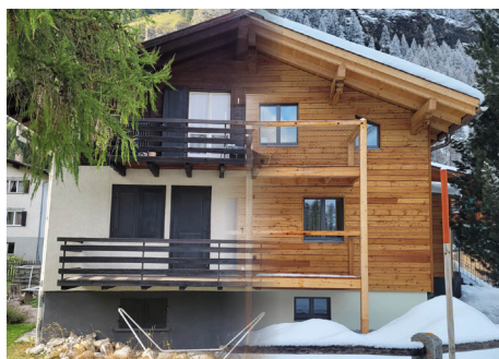
Fotomontage eines Einfamilienhauses vor und nach der energieeffizienten Sanierung. (Foto: Naturpark Beverin, Reiner Schilling)
