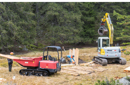
Die Spundwände halten das Wasser im Hochmoor Nursera – oberhalb von Andeer. Nun kann das regenerierte Hochmoor wieder als Wasserspeicher dienen und die umliegenden Gebiete mit Wasser versorgen. (Foto: Naturpark Beverin, Fabian Freuler)
