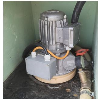
La **pintga ovra hidraulica**, ca vean fatg ir cun l'aua digl dutg, porscha forza electrica par l'alp Curtginatsch. Digls tains c'igl vean duvro zund bleara forza electrica, tànscha la turbina d'aua dantànt betga ad igl dovrà ultra da quegl egn generatur da diesel.
